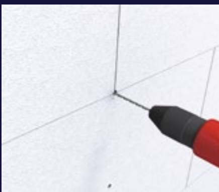
5 Taladro de soporte para anclaje mecánico.
