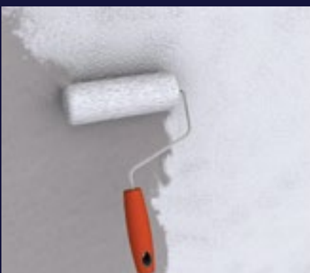
11 Aplicación de una mano de imprimación rhonatherm PRIMER para mejorar la adherencia con la capa final, dar uniformidad de color y regular el grado de absorción.
