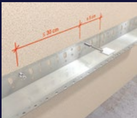
1 Posicionamiento del perfil de arranque.
