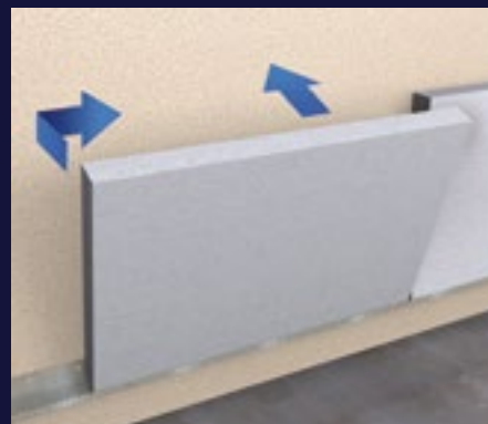
3 Pegado de los paneles termoaislantes sobre el perfil de arranque ensamblándolos desde abajo.
