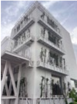
Rehabilitada con SATE
