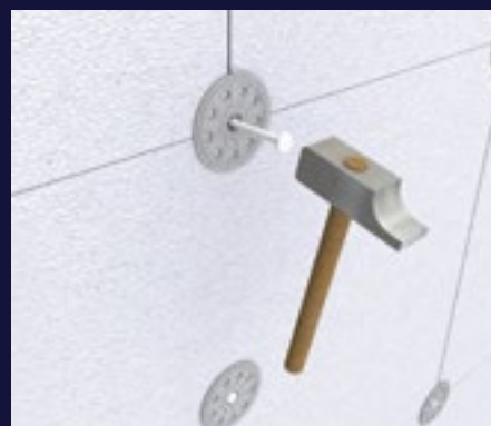
6 Inserción y clavado de los tacos de fijación.
