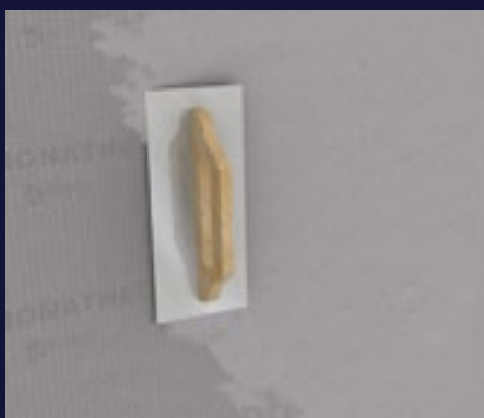
10 Tendido de una segunda capa de mortero cola RHONA T-700 una vez seca la primera capa.
