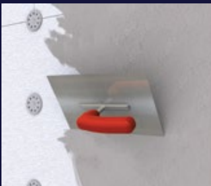
8 Tendido de una primera capa fina de mortero cola RHONA T-700 sobre la superficie.
